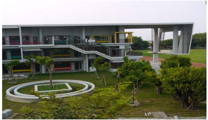
雲林縣立土庫國中校舍工程完工情形 (雲林縣政府提供)
