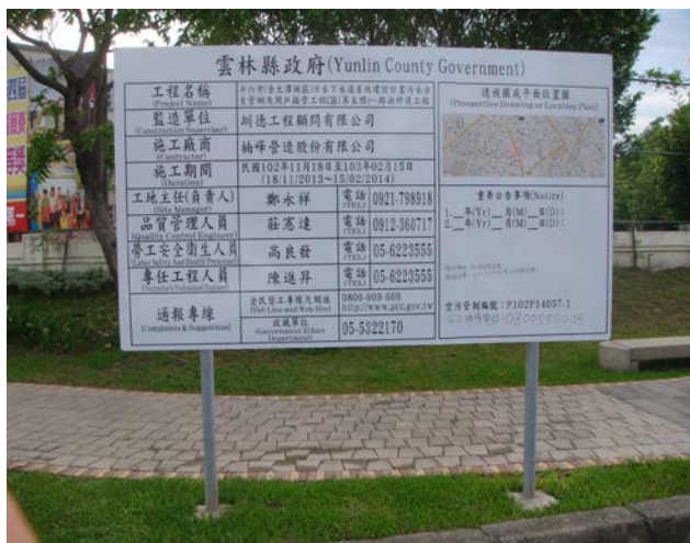
雲林縣政府工地現場之工程告示牌 (103年5月12日拍攝)
