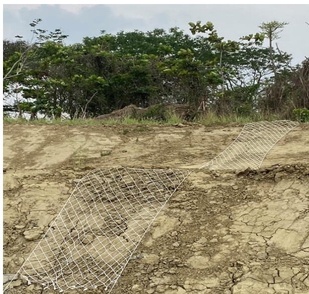
高雄有機示範園區生態農塘纜網設置情形 (高雄市政府農業局提供)
