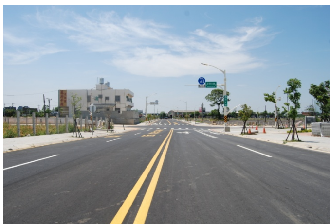
桃園中路地區區段徵收工程完工現況 (桃園市政府工務局提供)
