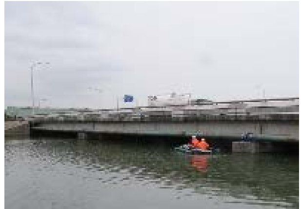
臺中市橋梁檢測作業 (臺中市政府建設局提供)
