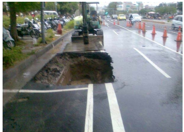
道路挖掘工程 (取自臺南市政府網站)
