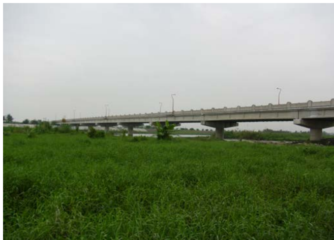
屏東縣龍港大橋改建工程完工後側面全貌 (屏東縣政府提供)
