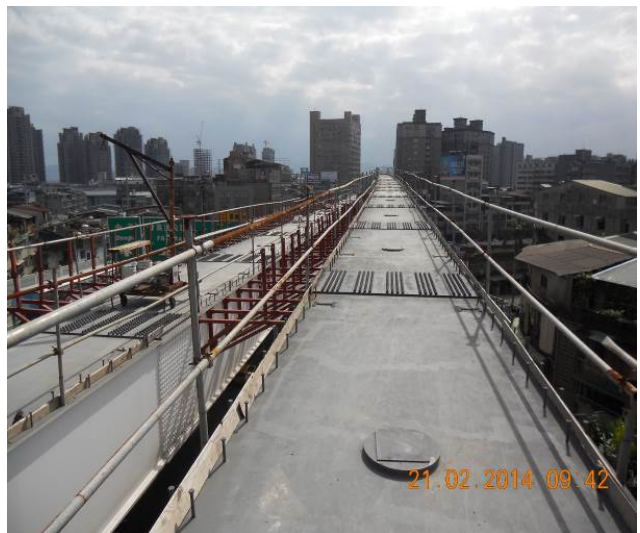
新北市捷運環狀線CF651B 標高架路段施作情形 (103 年 2 月 21 日拍攝)
