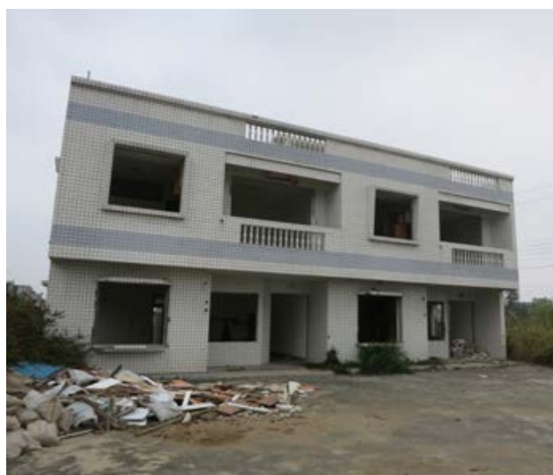
嘉義市湖子內區段徵收工區內待拆除建築物 (嘉義市政府提供)
