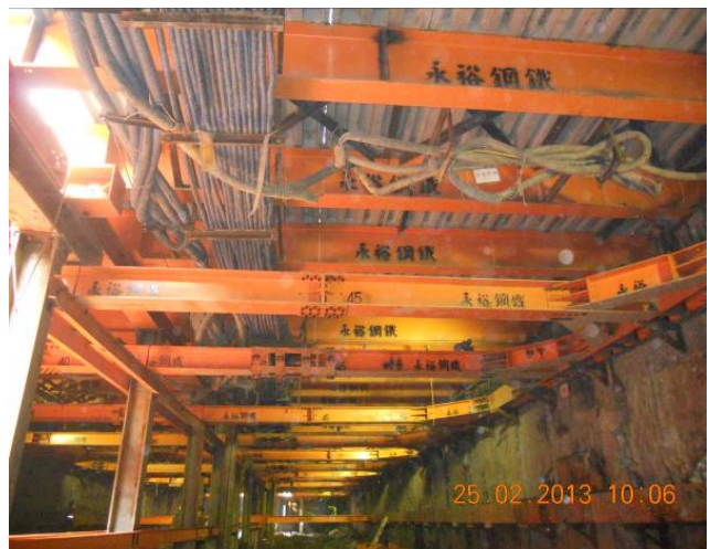
捷運環狀線 Y6 站地下擋土支撐施作情形 (102 年 2 月 25 日拍攝)
