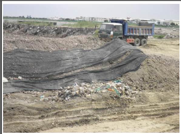
圖二：廢棄物開挖清運照片 (100年8月12日現場拍攝)
