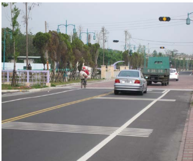
西螺鎮 I-1 號道路改善工程完工通車情形 （雲林縣西螺鎮公所提供）
