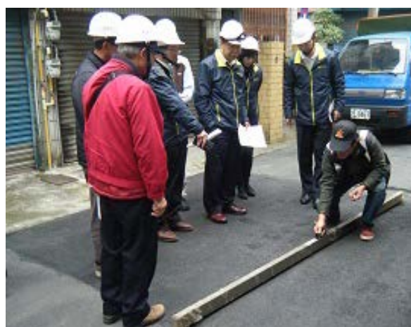
新竹市管線挖掘道路品質抽驗情形 (擷取自新竹市政府「新竹市路平主題
