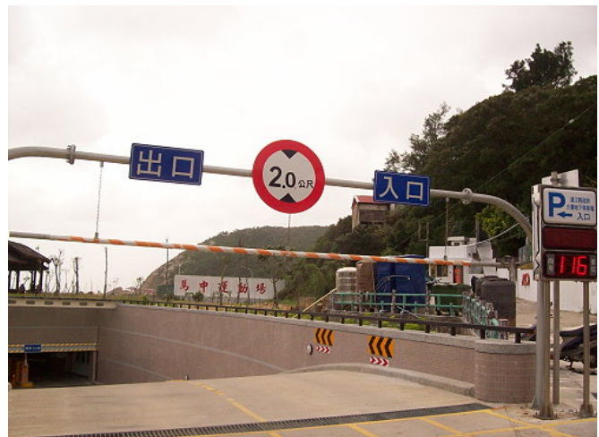
連江縣介壽停車場出入口 (擷取自連江縣馬祖日報社網站)
