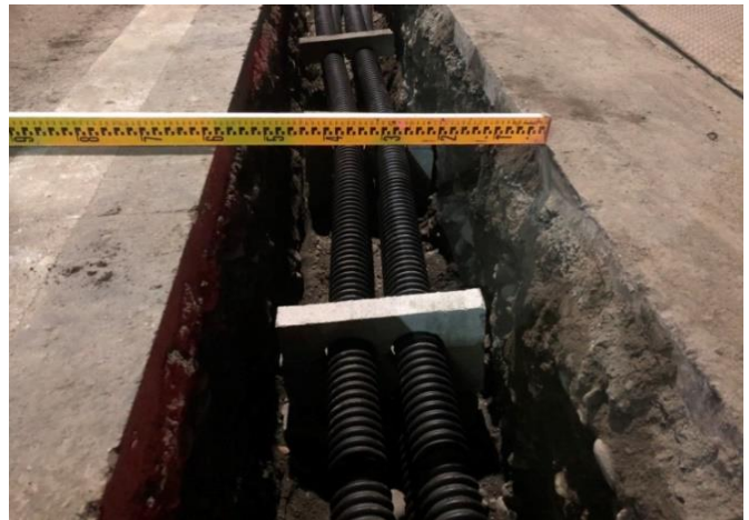
嘉義縣民雄鄉共同管道(纜線管路)建置情形 (嘉義縣民雄鄉公所提供)
