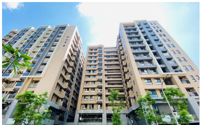
臺北市大同區斯文里三期整宅公辦都更統包工程 （臺北市都市更新處提供）
