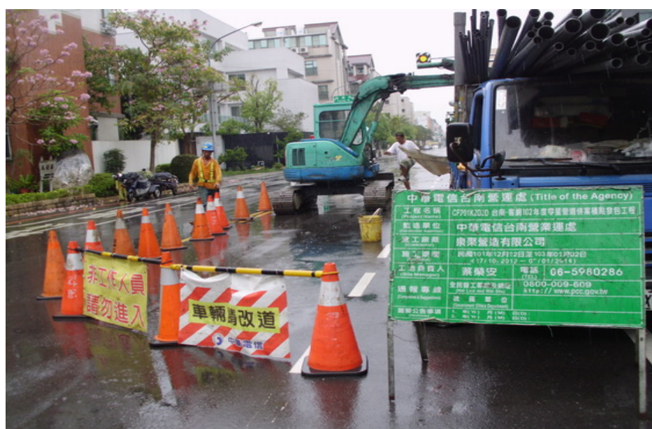
申挖單位施工情形 (臺南市政府工務局提供)
