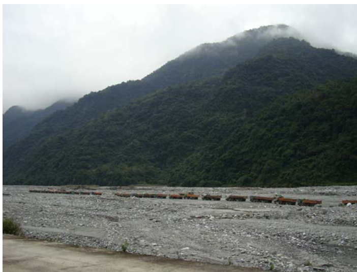
花蓮縣壽豐溪上游疏濬工程投標廠商借用他人名義投標 (花蓮縣政府提供)
