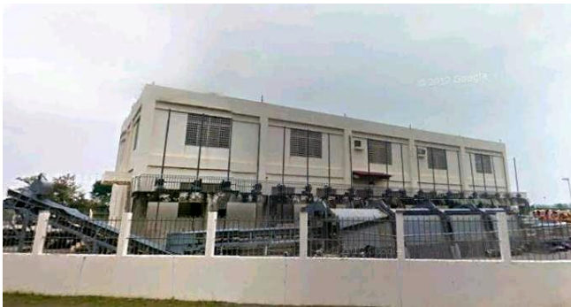
圖 1 臺南市 C3 抽水站外觀圖(取自 Google 100 年 11 月街景)
