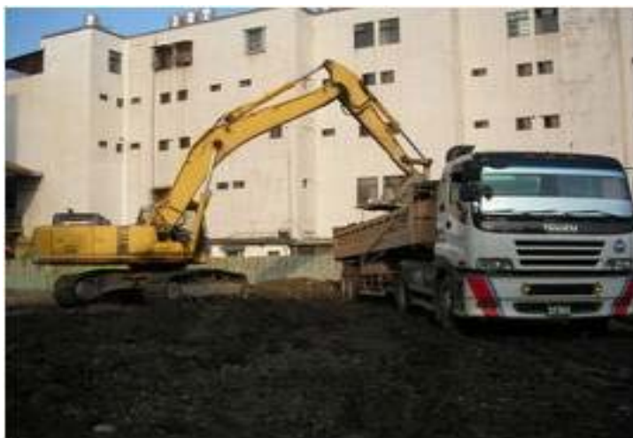
高雄市公共工程土方交換挖運作業 (高雄市政府工務局提供)
