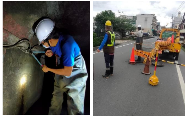
宜蘭縣雨水下水道附掛纜線清除遷移作業 (宜蘭縣政府提供)
