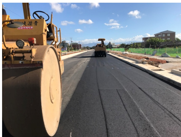
桃園市道路改善工程施工情形 (桃園市政府新建工程處提供)
