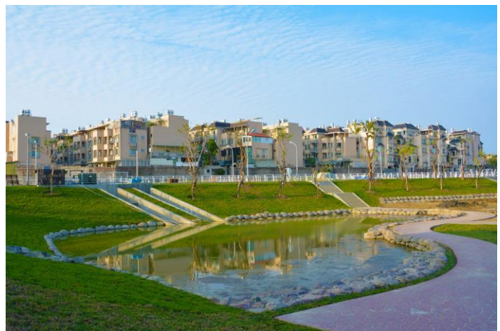
高雄市北屋排水整治完工之公園滯洪池 (高雄市政府水利局提供)
