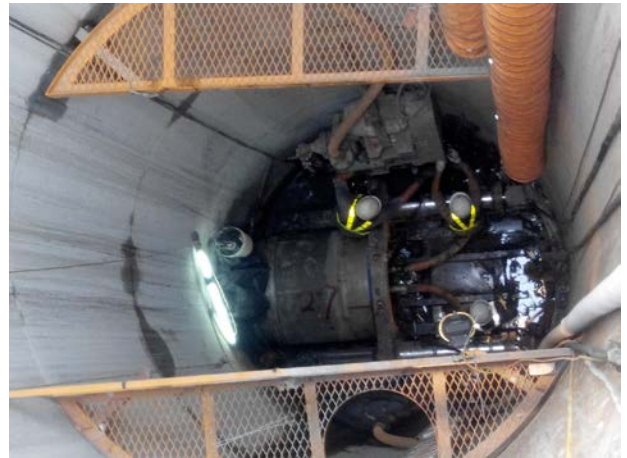
臺南市公共污水下水道施工情形 (臺南市政府水利局提供)
