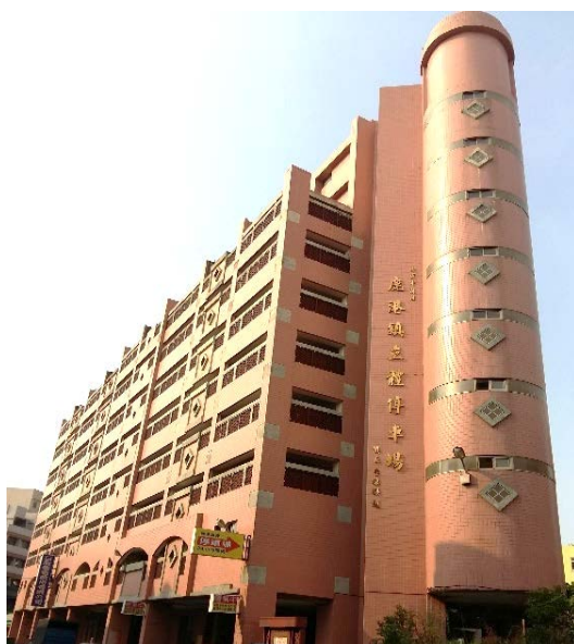
彰化縣鹿港鎮停一停車場 (彰化縣鹿港鎮公所提供)
