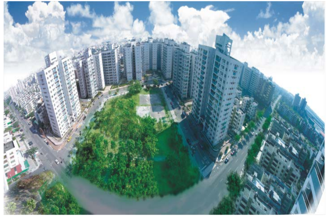
臺南市新興二、三期國宅現況實景 (臺南市政府都市發展局提供)
