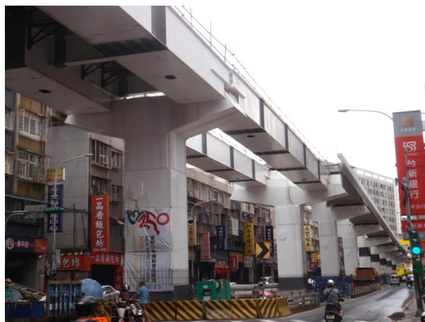
捷運環狀線第一階段施工情形 (新北市政府捷運工程局提供)
