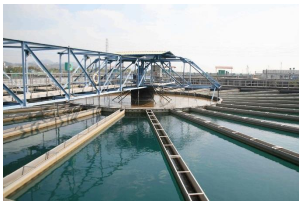
鯉魚潭淨水場淨水加藥處理情形 (台水公司提供)
