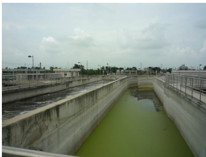
官田區污水處理廠閒置未用氧化渠池 (101年5月3日拍攝)
