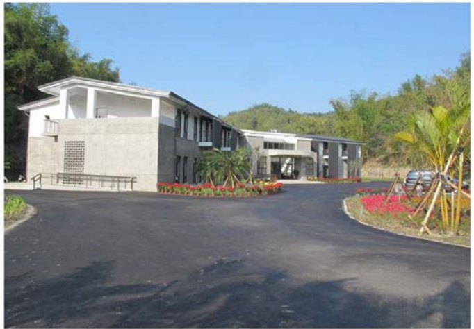
高雄市政府工務局養護工程處旗美養護工程隊辦公室外觀 （高雄市政府工務局提供）
