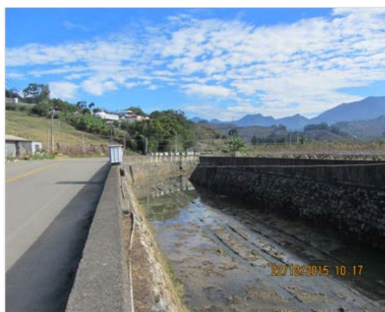
苗栗縣老庄溪排水治理工程 (104 年 12 月 22 日拍攝)
