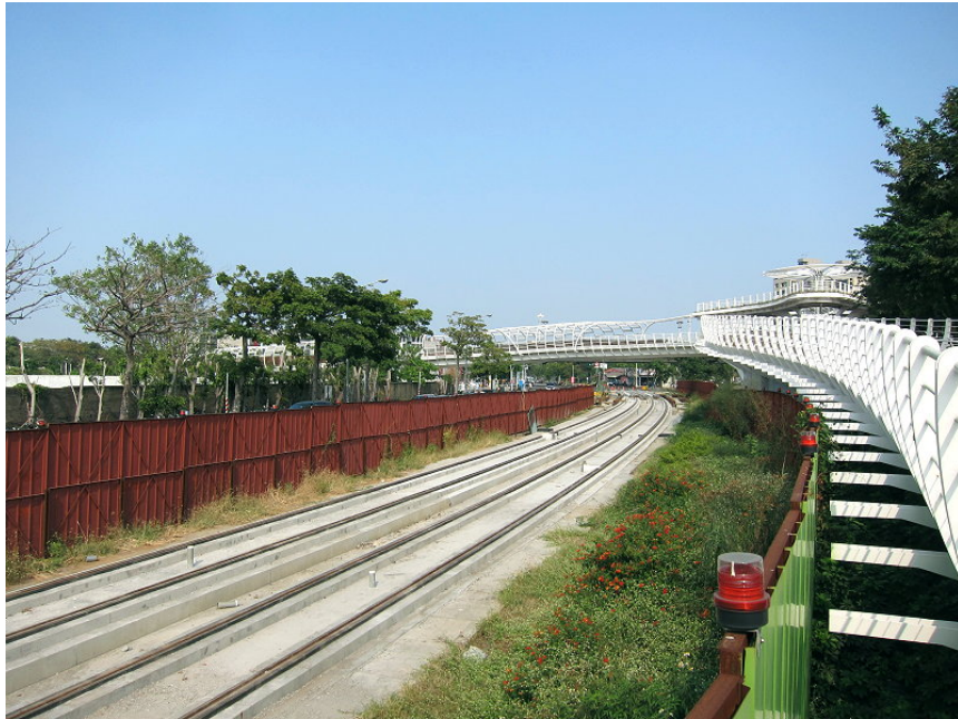
高雄環狀輕軌捷運工程屬自償性公共建設計畫 (103 年 11 月 1 日實地拍攝)
