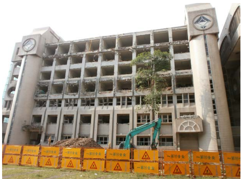
高雄市立空中大學宿舍大樓整修情形 （高雄市立空中大學提供）
