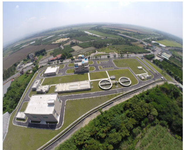
旗美污水處理廠現況 (高雄市政府水利局提供)
