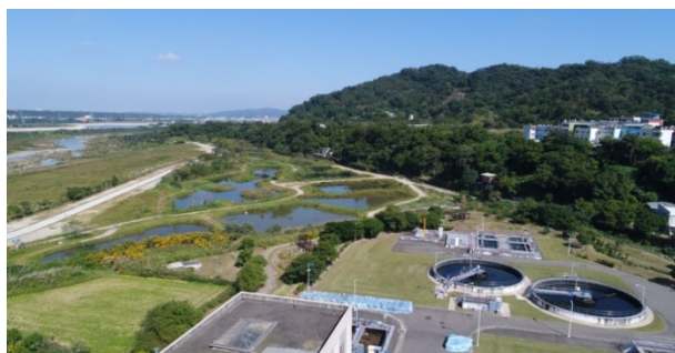
大溪排水自然水質淨化工程 (桃園市政府水務局提供)
