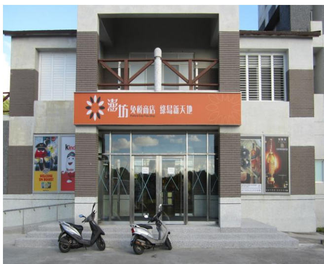
臺東縣綠島南寮漁港交通碼頭候船室(免稅商店) (臺東縣政府提供)
