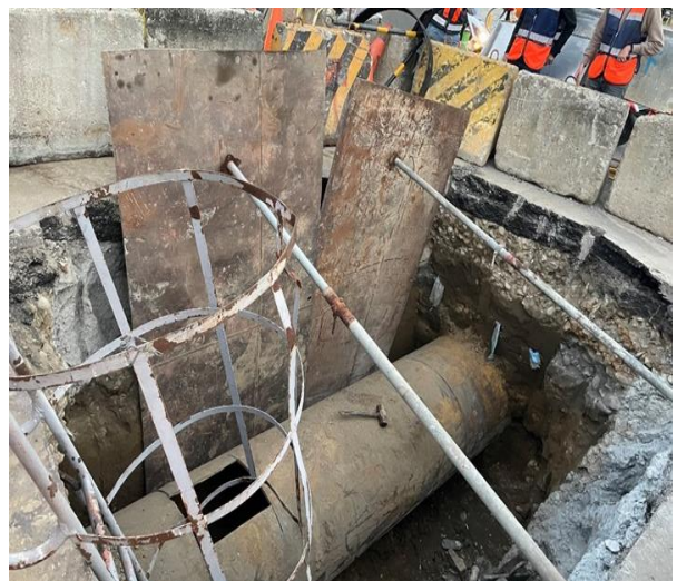
自來水管線改接作業示意 (台灣自來水公司提供)
