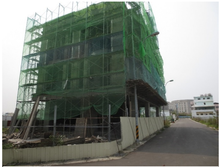
彰化縣員林市公所開徵建築工地臨時稅工地建築情形 (彰化縣審計室自行拍攝)
