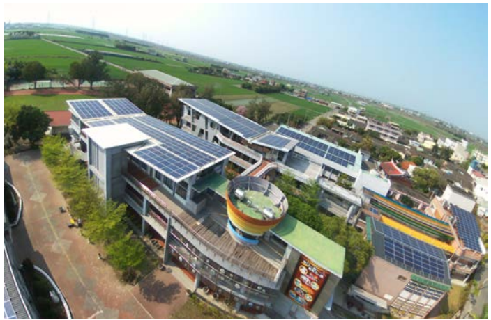
嘉義縣溪口國小房舍屋頂太陽能光電設備建置情形 (嘉義縣政府提供)
