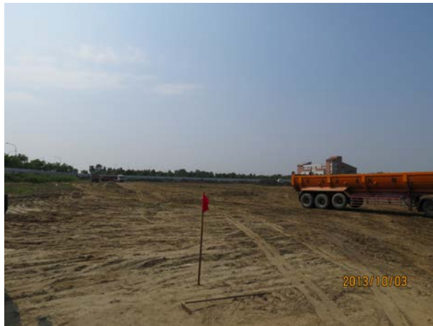
填土工程施工中街廓
