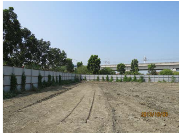
填土工程完成街廓
