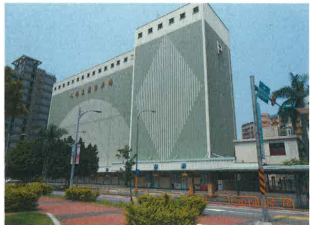
臺北市八德立體(機械)停車場 (臺北市停車場管理工程處提供)
