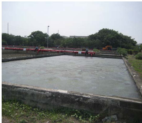
經濟部工業局大發污水處理廠-曬乾床 (經濟部工業局提供)
