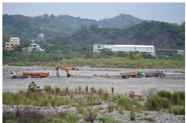
石岡壩疏濬作業情形 (經濟部水利署提供)
