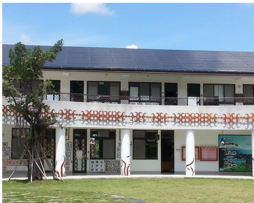
屏東縣泰武國民小學校舍屋頂裝置太陽光電發電系統 (102 年 11 月 27 日拍攝)
