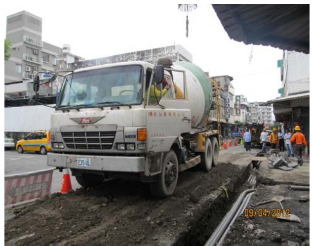
臺東市區挖掘道路埋設管線施工情形 (臺東市公所提供)
