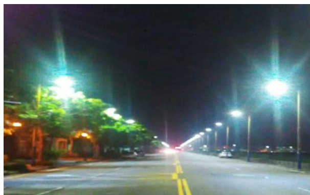
嘉義縣水銀路燈汰換為 LED 路燈 （嘉義縣政府建設處提供）
