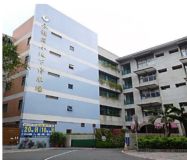
新北市永福國小地下停車場 (新北市三重區永福國民小學提供)
