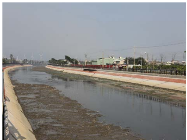
臺中市清水區清水大排整治情形 (臺中市政府提供)
