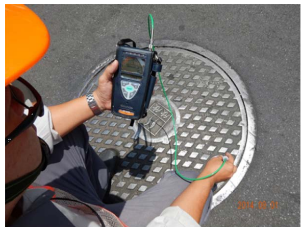
臺北市公用天然氣事業辦理管線檢查情形 (臺北市政府產業發展局提供)
