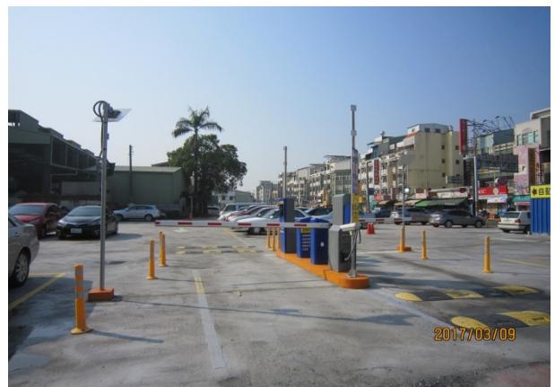
嘉義市南門二小段 87 地號等市有土地 闢建為路外臨時停車場現況 (嘉義市政府提供)
